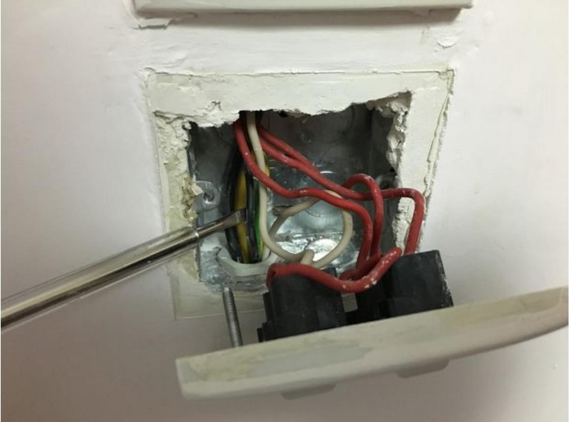
与许多远程接收器相同，ESP8266 需要直流电才能工作，因此需要一个 AC / DC 转换器。然而，在某些情况下，开关插座可能只有火线，但没有零线。在这种情况下，它不能在插座中提供直流电流。
